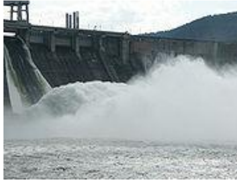
Fig.2.14. Centrale idroelettrica russa
