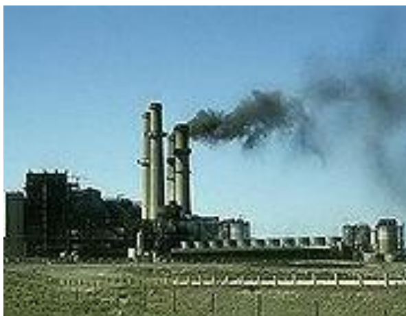
Fig.1.1. Centrale termoelettrica in Iraq
